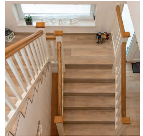
Geländer über Betonkern
